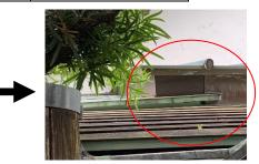
雨漏り修理調査をして修繕していきます 今回は大きく穴が開いていた為、塞ぐ工事をしていただきました
